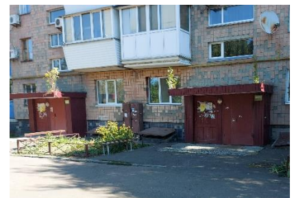
Фото. Відсутність урн біля житлових будинків
