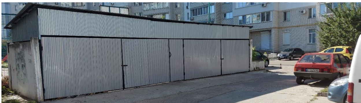
Фото. Контейнерний майданчик з огороження та накриття
